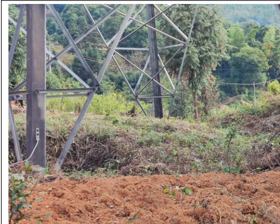
2#塔基区植被恢复
