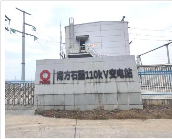
南方石墨 110kV 变电站大门
