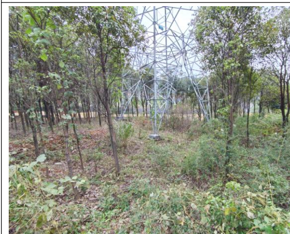
16#塔基区植被恢复
