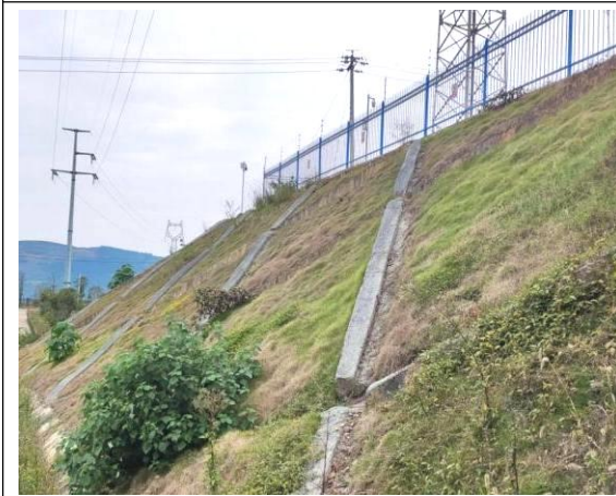
变电站南侧边坡排水沟及绿化
