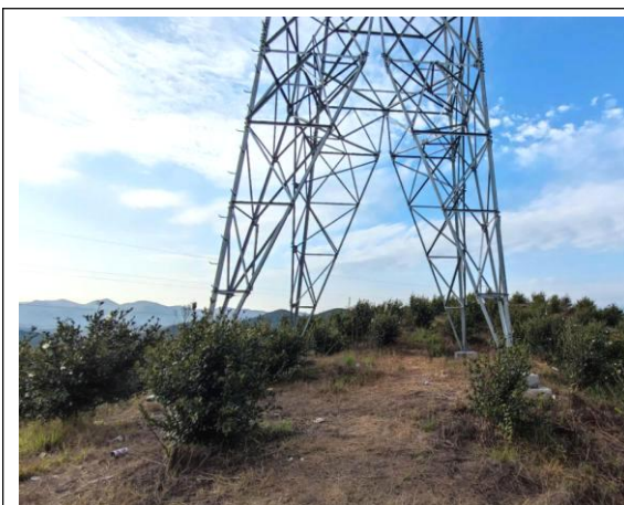
6#塔基区植被恢复
