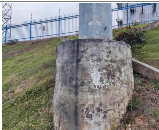
18#塔基区植被恢复
