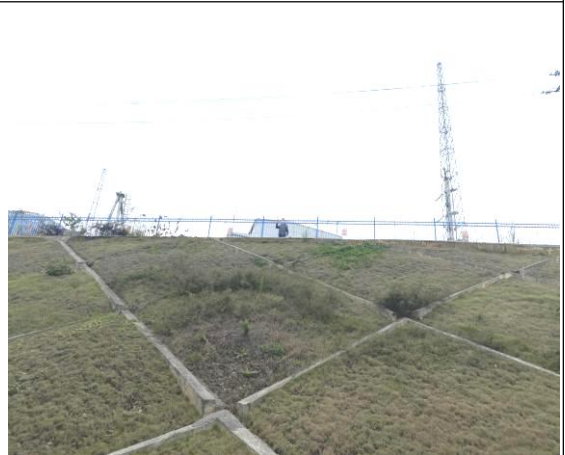
变电站西侧边坡排水沟及绿化
